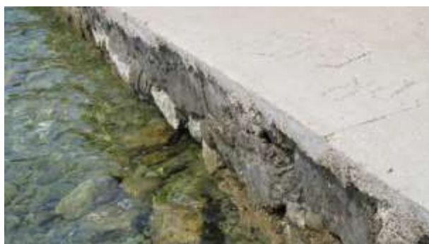
Odnešen postojeći nasip ispred nožice zida šetnice
