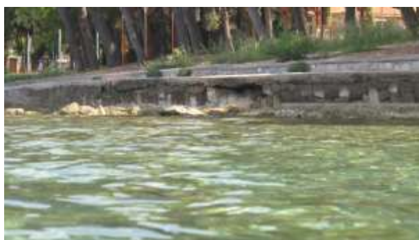
Obalni zid sa šetnicom
